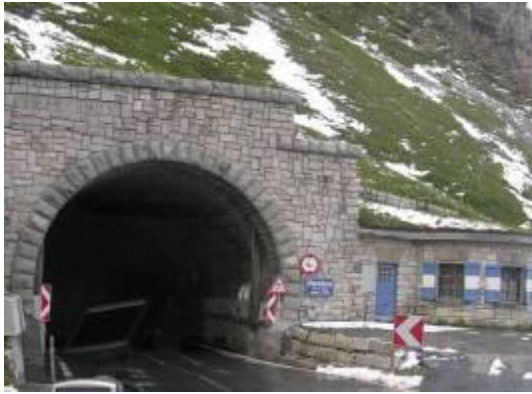
Figura 50. Mittertörltunnel (2.328 m de altitud y 117 m de longitud). Los túneles de la carretera tienen emboquilles de piedra, que aportan una seña de identidad propia a la de por sí trascendencia histórica que tuvo su inauguración.
