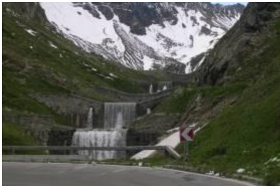
Figura 51. Diques junto a una curva de la carretera.
